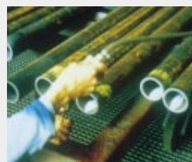
Einblasen von VCI-Pulver zum inneren Schutz von Rohren (F)
