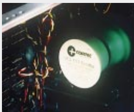
Schutz eines Schaltschranks mit VCI-Spender in einer Kunststoffschale, selbstklebend, nicht staubend, auch für Reinräume geeignet, Höhe ca. 20 mm, Durchmesser ca. 60 mm (A)
